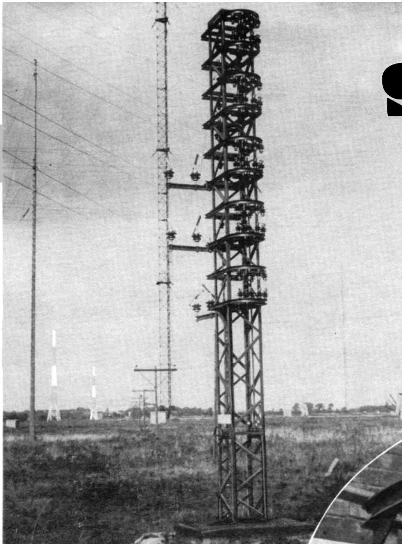
Ein Mast, auf dem die Umschaltvorrichtungen angebracht sind, die es leicht machen, von einer Antenne auf die andere überzugehen.
